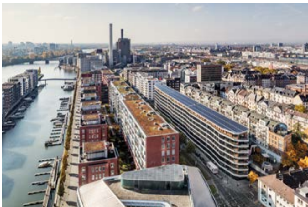
Das große Pultdach als Energiequelle ↓
