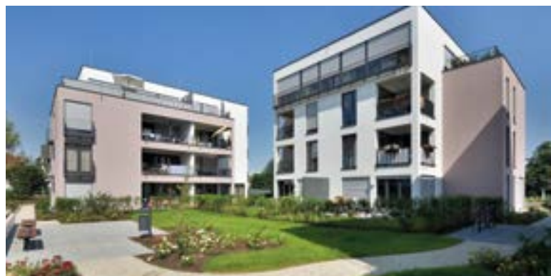
Weiträumige Grünflächen zwischen den Häusern ↑
