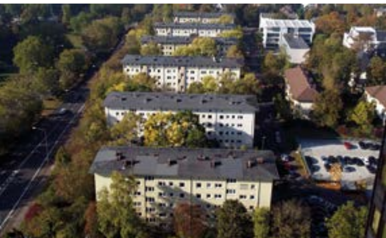
Luftbild vor dem Abriss ↑
