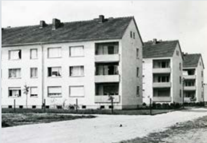
Historische Aufnahme der Zeilenbauten kurz nach Fertigstellung ↑
