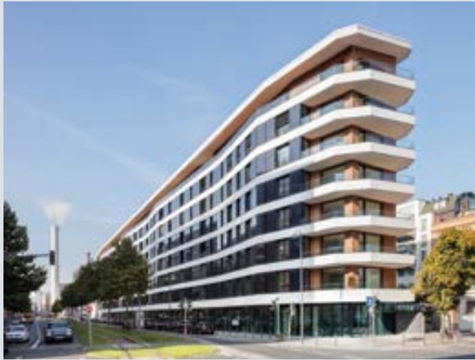
Die 150 Meter lange Photovoltaik-Fassade ↑
